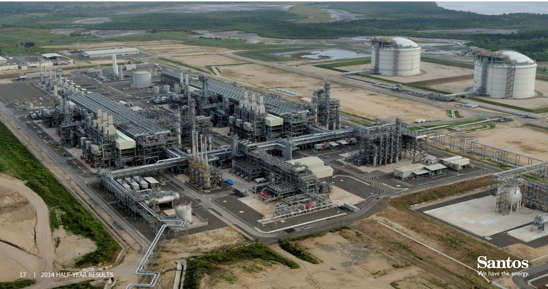
PNG LNG plant
