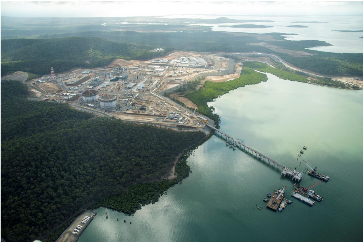
LNG plant site on Curtis Island, September 2013.
