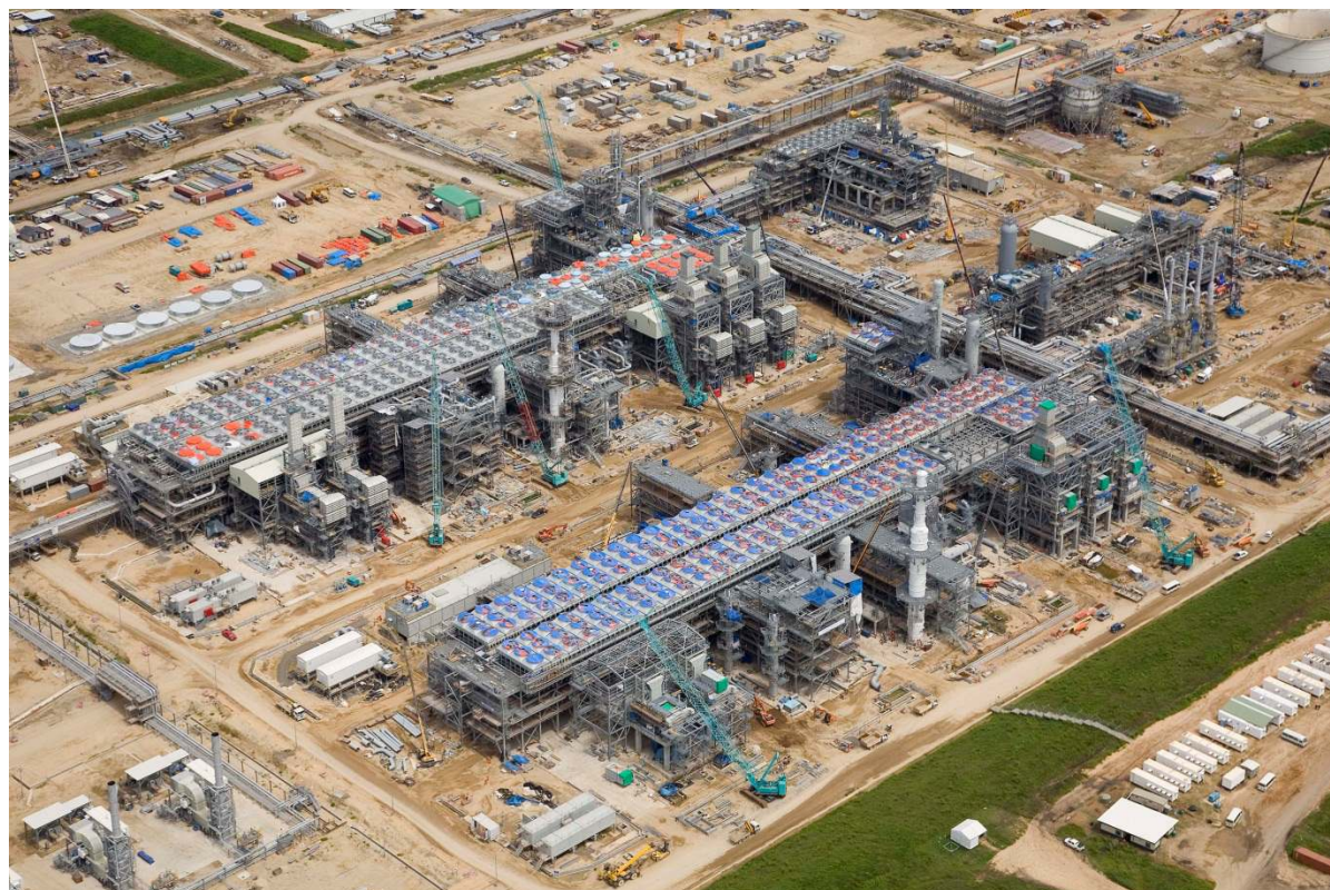
LNG plant site, March 2013
