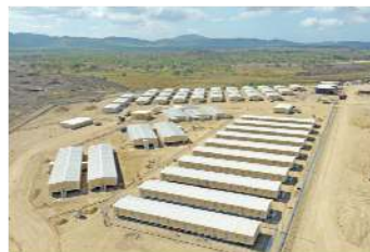
LNG plant site construction camp
