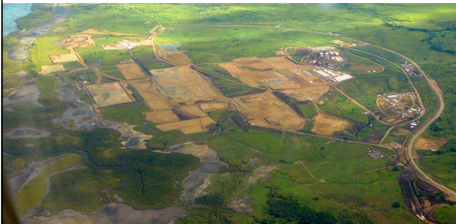
PNG LNG plant site, Port Moresby
